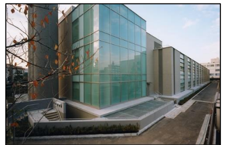
現 上石神井庁舎電算棟/練馬区
